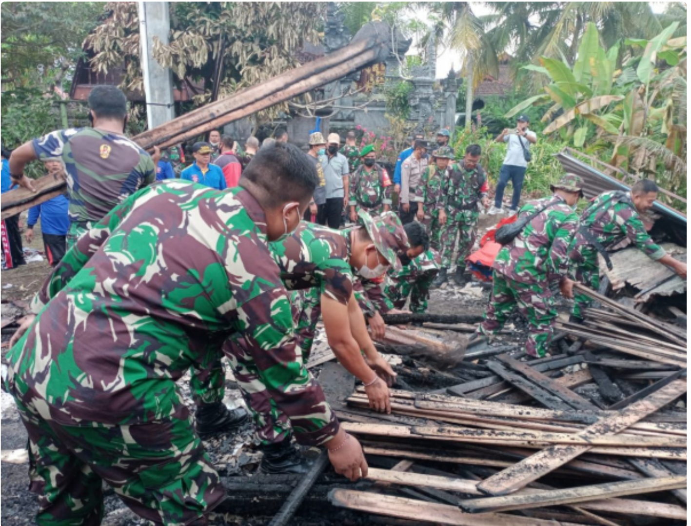
Bersihkan sisa puing-puing bekas kebakaran
